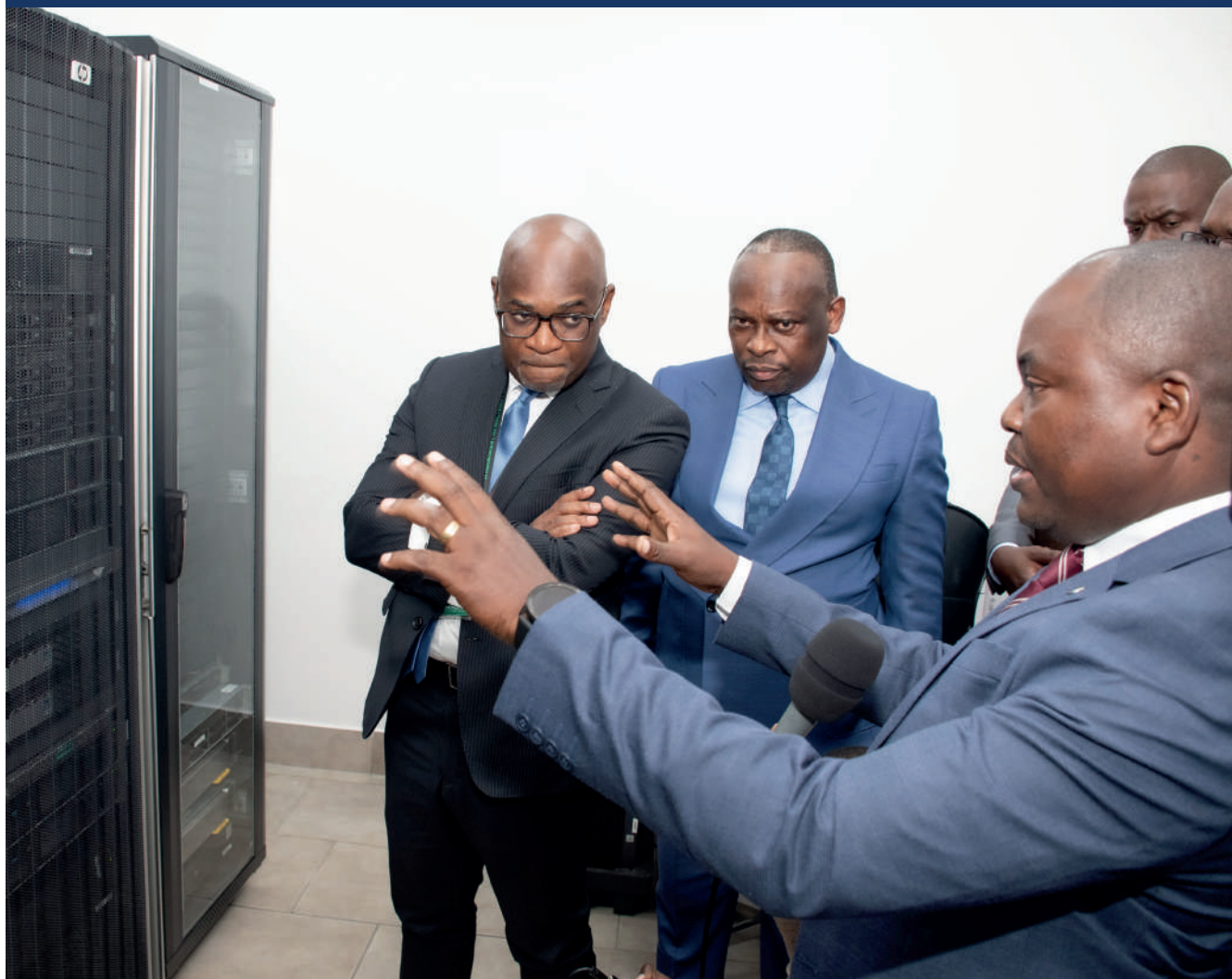
Déscente du Ministre des Finances au Data center du GUOT à Pointe-Noire
